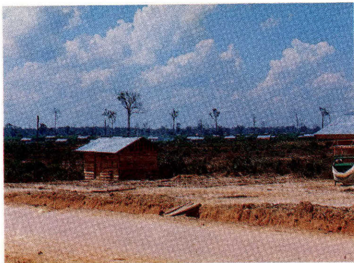
PERUMAHAN TRANSMIGRASI LOKAL MESUJI A ( GAMBAR 15 ).
