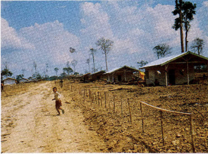
PERUMAHAN TRANSLOK YANG SEDANG DAN SUDAH DIBANGUN UNTUK DITEMPATI. ( GAMBAR 11 ).
