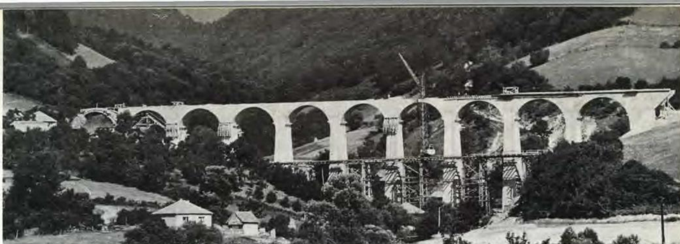
FIG. 4 - Construction d'un pont sur la ligne de chemin de fer Sarajevo-Plöce (Yougoslavie). Depuis 1949, date du premier prêt de la Banque Mondiale à la Yougoslavie, une somme de 260 millions de dollars a été avancée pour développer l'agriculture, les centrales électriques, l'industrie et les transports.
