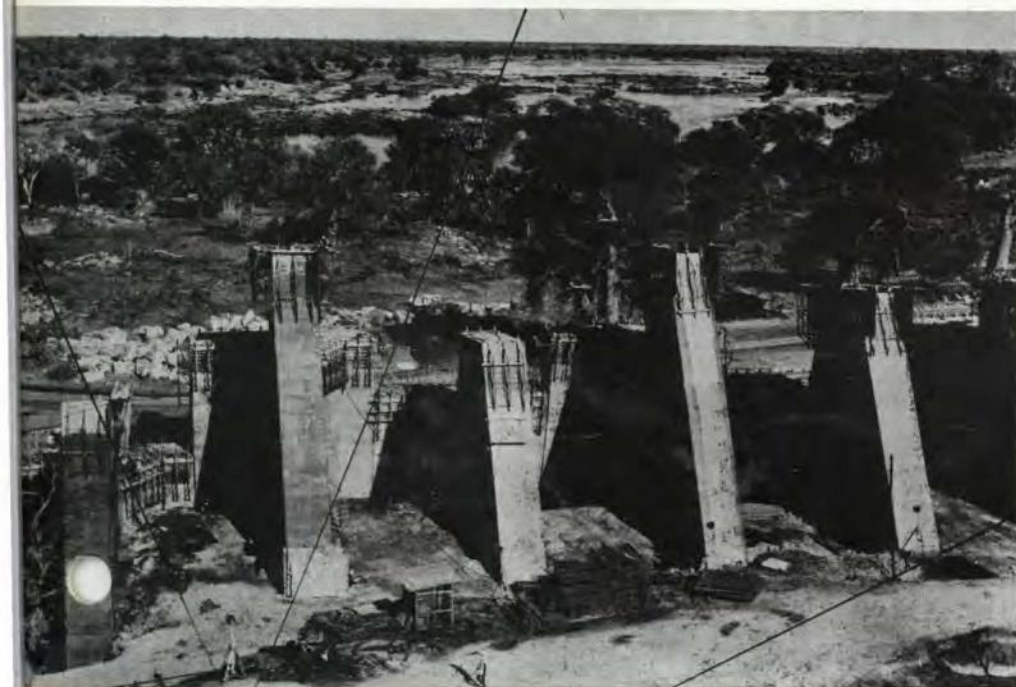
FIG. 2 - Construction du barrage de Roseires sur le Nil bleu (Soudan). La Banque Mondiale et l'I.D.A. (International Development Association) se sont associées pour mettre à la disposition de la République du Soudan un montant de 32 500 000 dollars. Ce barrage permettra, en période de sécheresse, de doubler les quantités d'eau disponibles pour l'irrigation.
