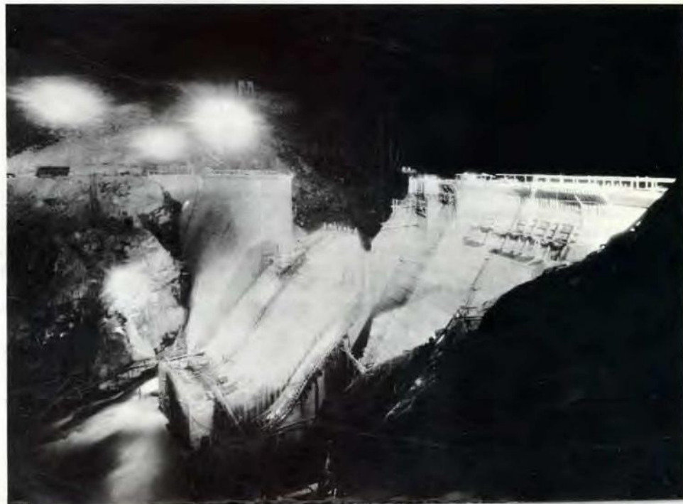
FIG. 2 — AUSTRALIE — Le barrage d'Island Band sur la Snowy River est un ouvrage fonctionnant par gravité qui fait partie d'un ensemble de développement des Montagnes Neigeuses dans le sud-ouest de l'Australie. La partie financée par la Banque Mondiale représente une capacité de production de 760 000 kilowatts.
