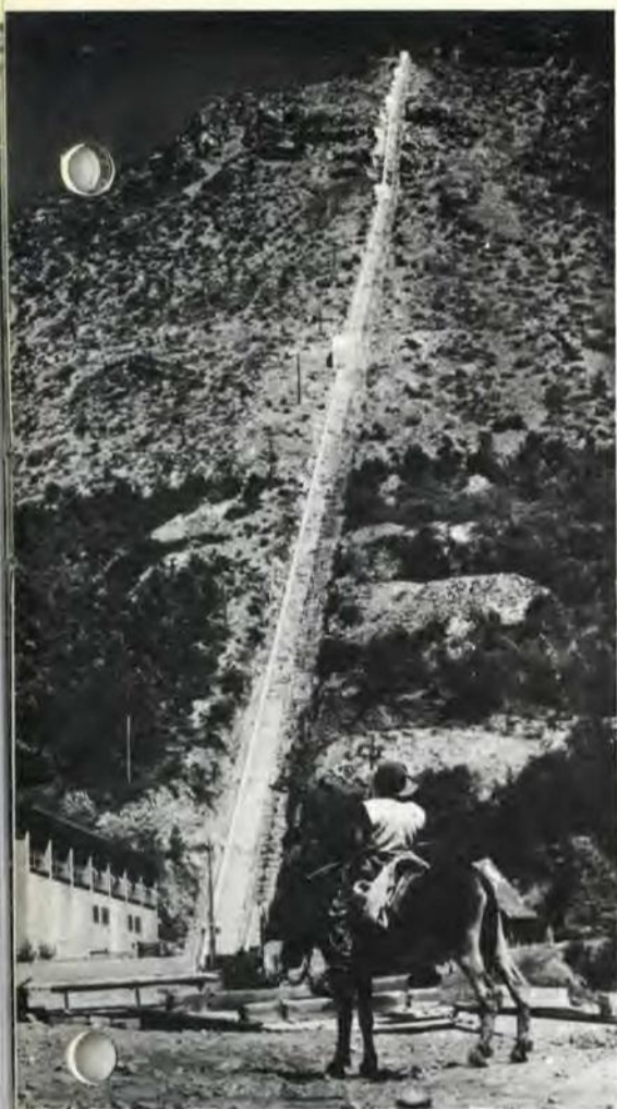
FIG. 6 — L'usine hydro-électrique de Los Molles au CHILI fut un des premiers projets de développement financés par la Banque Mondiale.
