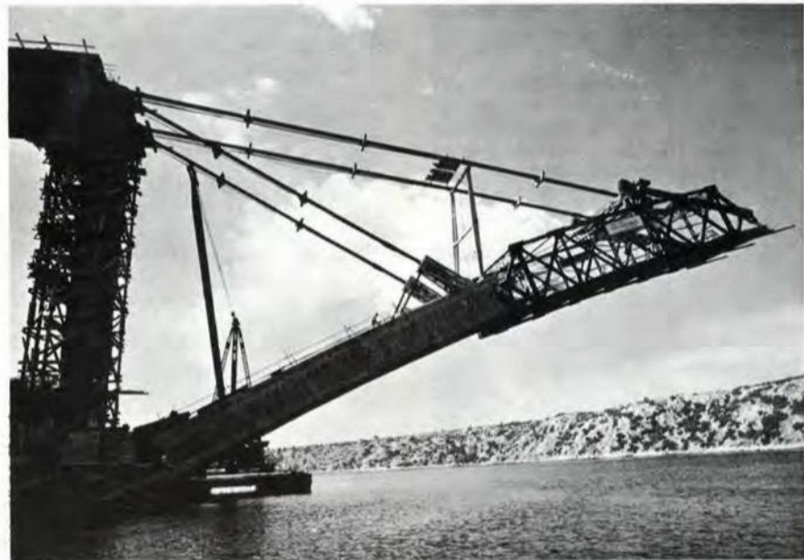
FIG. 5 — YOUGOSLAVIE — Sur la route adriatique yougoslave, construction d'un nouveau pont sur la rivière KRKA, à 6 km de Sibenik.
