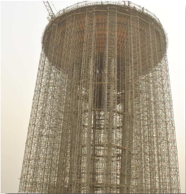
Château d'eau en construction
