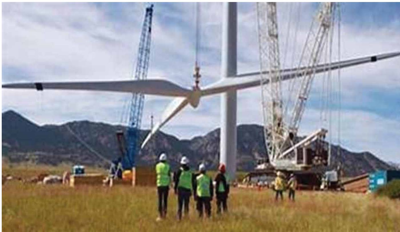
Construction d'un champ d'énergie éolien en Afrique
