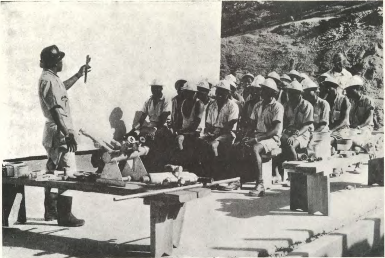
Travailleurs indigènes, au projet hydroélectrique de Kariba Gorge sur le Zambèze, recevant une instruction sur le marteau pneumatique.
