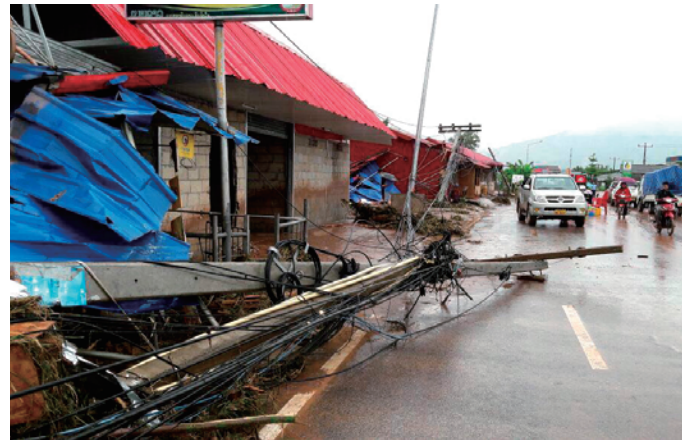
2017年にラオス・ウドムサイ県で発生した洪水で路上に倒れた電柱 (出典：世界銀行)
