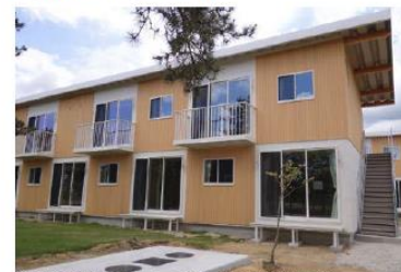
常設型住宅（長屋・戸建：能登半島地震）
