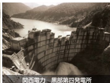
関西電力 黒部第四発電所
