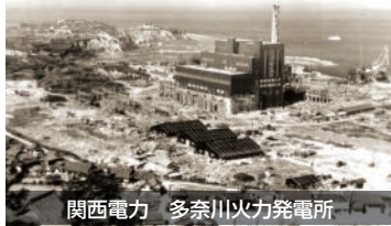
関西電力 多奈川火力発電所
