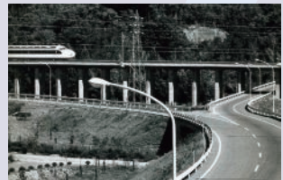
世銀借入で建設された東海道新幹線 が東名高速道路を横切る様子
