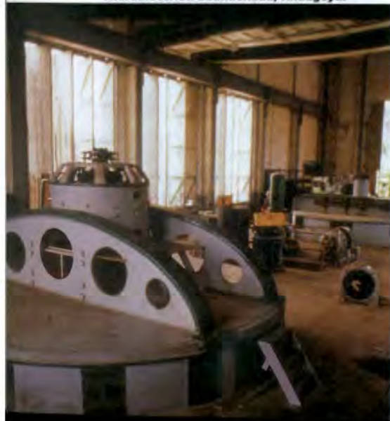
Hidroeléctrica abandonada, Andagoya.
