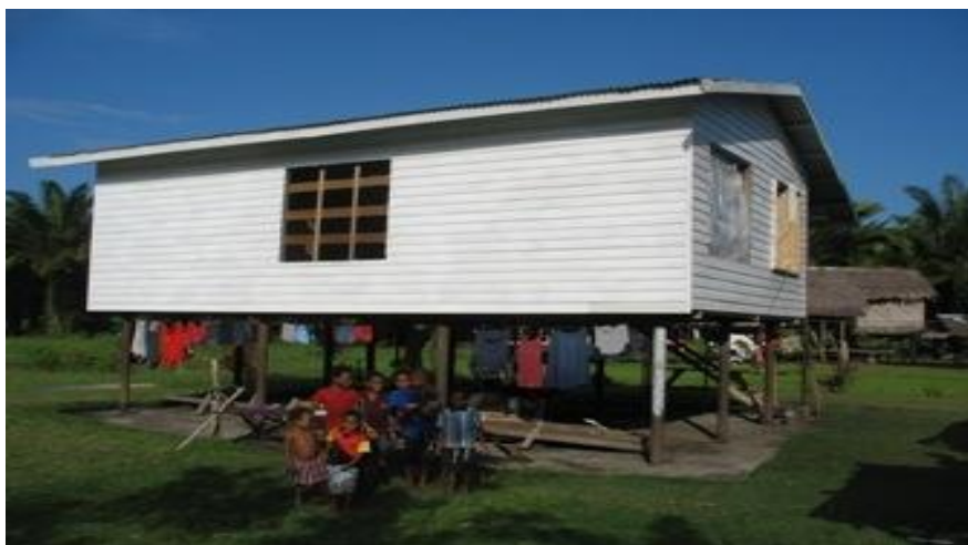
Piksa 11: Lukluk long wanpela ‘welpam’haus long fran, na wanpela lip-saksak haus long baksait, long WNB provins
