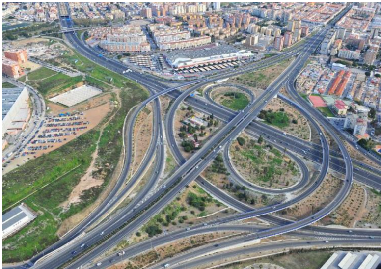
Figure 5. Échangeur entre les routes MA-20 et A-357. 12
