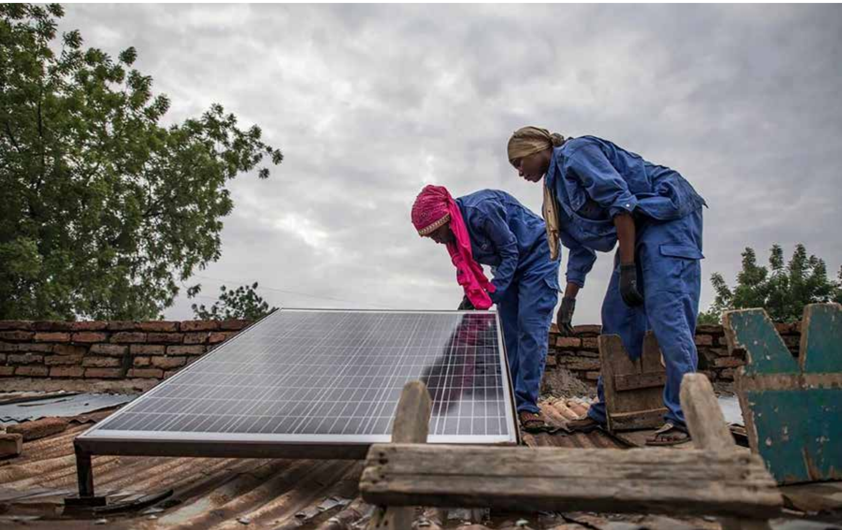
Installation de panneaux solaires au Tchad
