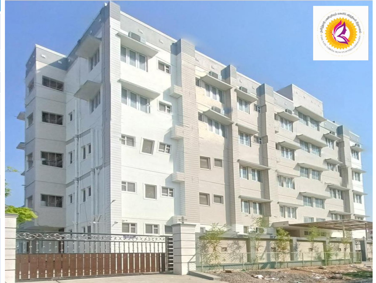
Actual Site photos – Guduvanchery
